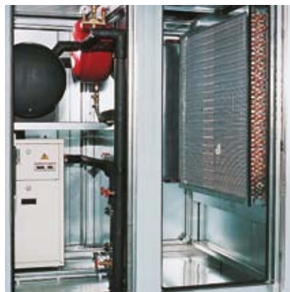
Indirekte Kühlung mit Kaltwassersatz
