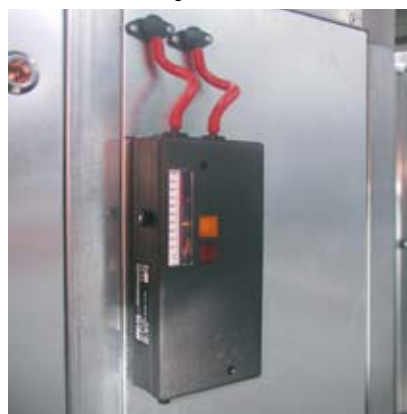
Differenzdruckmanometer (Filterüberwachung)
