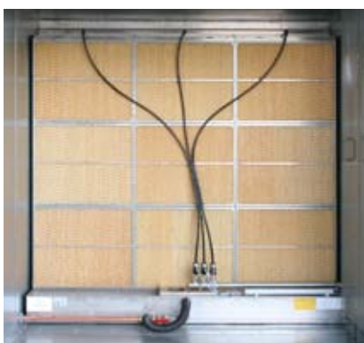
Tropfenabscheider für Hochdruckbefeuchter
