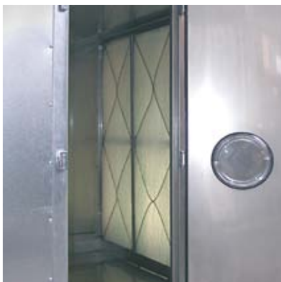
Tropfenabscheider für Hochdruckbefeuchter
