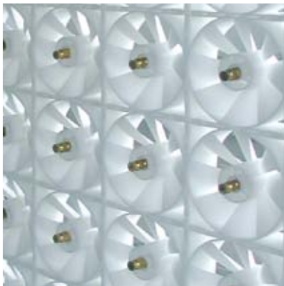
Hochdruckbefeuchter-Düsen
