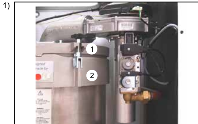
Stecker ①② abziehen (vorher Kreuzschlitzschrauben lösen)
