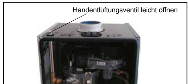
Bild: Manuelles Entlüftungsventil
