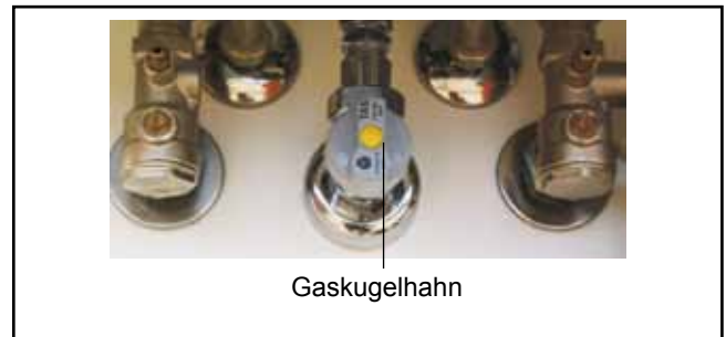
Bild: Absperreinrichtungen
