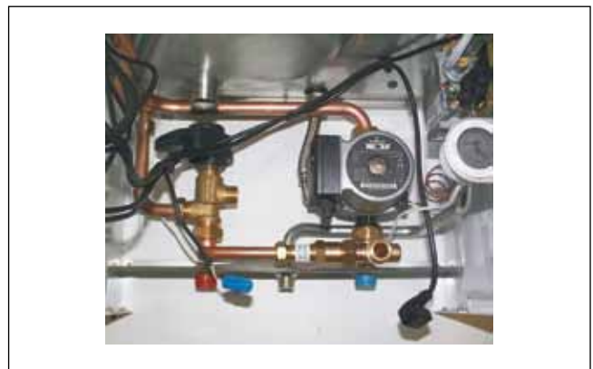
Bild: Anschlussblock demontiert
