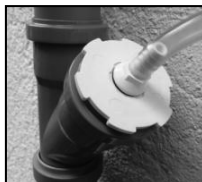
Abb. 2 Adapter 50/8 mm für Ablauf
