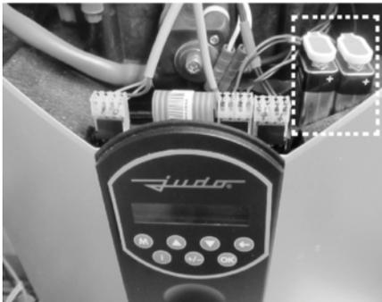
Abb. 10: Blockbatterien des Safety-Moduls
